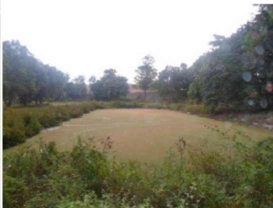
Foto 1.43 – ETE SEAC – Lagoa Anaeróbia
