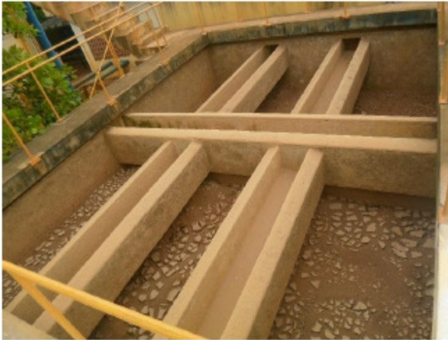
Foto 5.20 – Filtros aguardando troca de material filtrante
