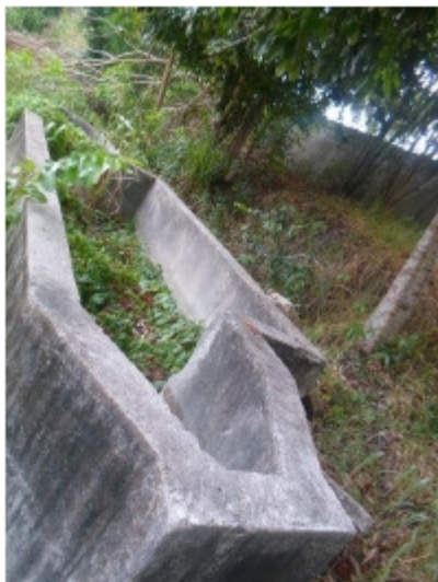
Foto 1.42 – ETE SEAC – Caixa de areia
