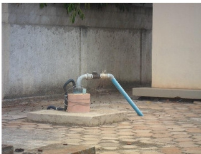
Foto 1.28 – Poço Santa Leocádia
