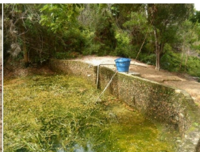
Foto 1.34 – Represa e aplicação de Cloro (Fonte: ENGECORPS, 2015)
