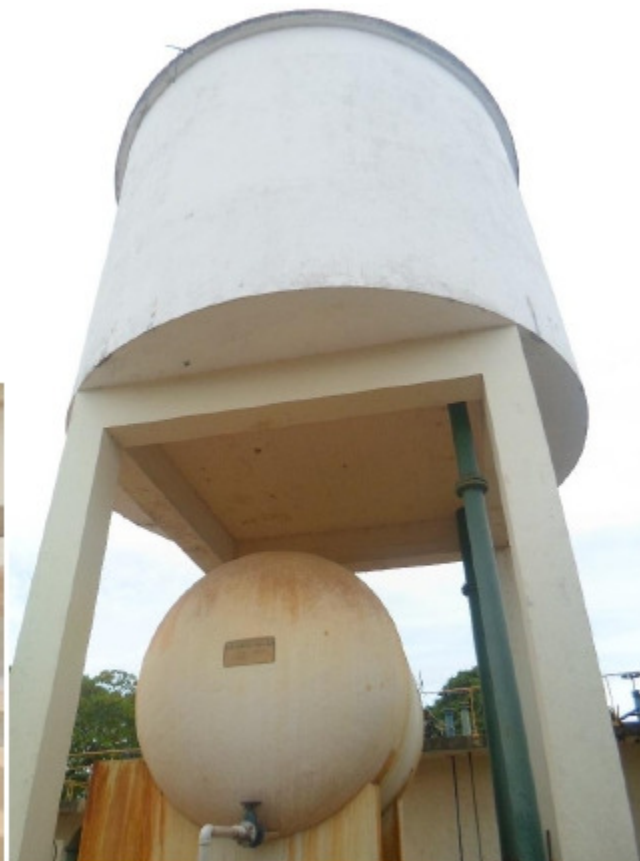
Foto 1.23 – Reservatório Elevado para Lavagem dos Filtros (Fonte: ENGECORPS, 2015)
