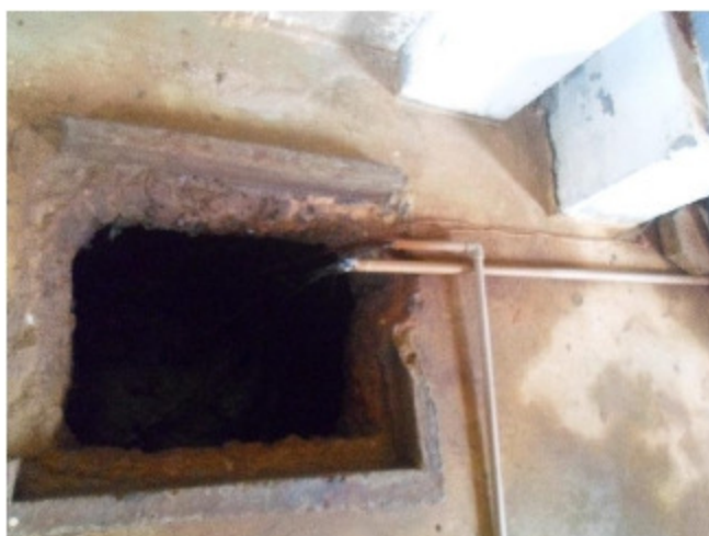
Foto 1.24 – Aplicação de Química no Tanque de Contato
