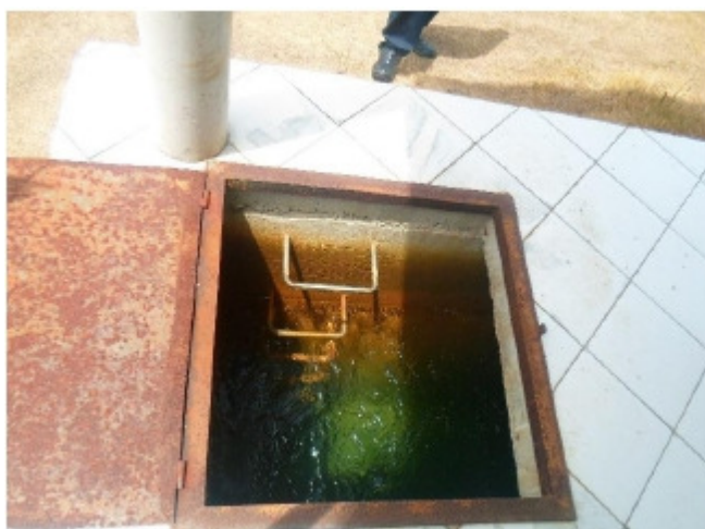
Foto 1.16 – Poço de Sucção EEAB Rio (Fonte: ENGECORPS, 2015)
