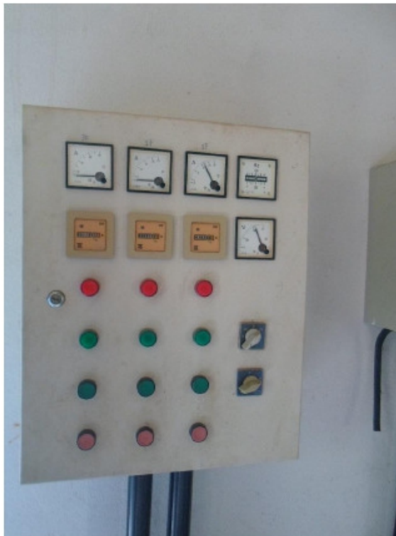
Foto 1.15 – Painel de Controle EEAB Rio Preto (Fonte: ENGECORPS, 2015)
