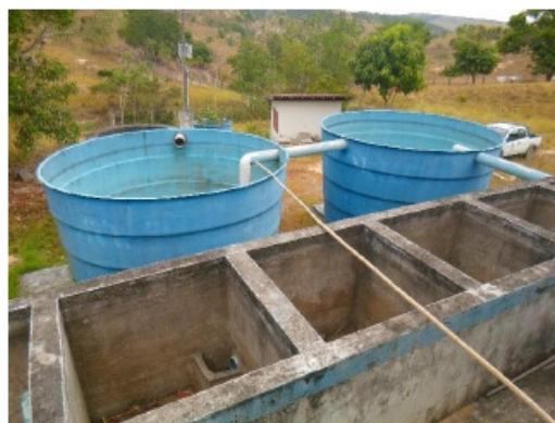
Foto 1.32 – ETA desativada (Fonte: ENGECORPS, 2015)
