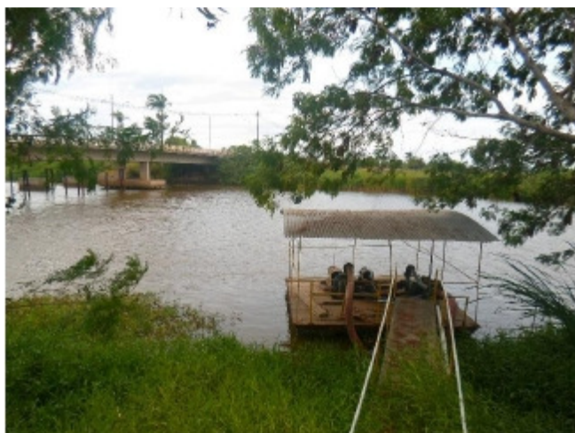
Foto 1.12 – Captação no Rio Mariricu
