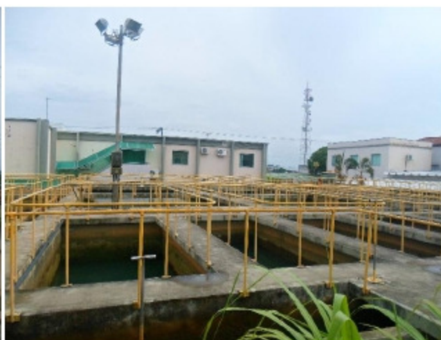
Foto 1.5 – Visão Geral das ETAs Sede
