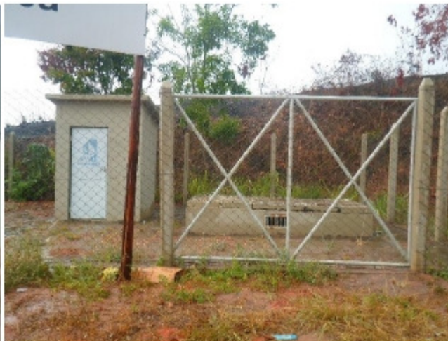
Foto 5.8 – Booster Unisan (Fonte: ENGEORPS, 2015)
