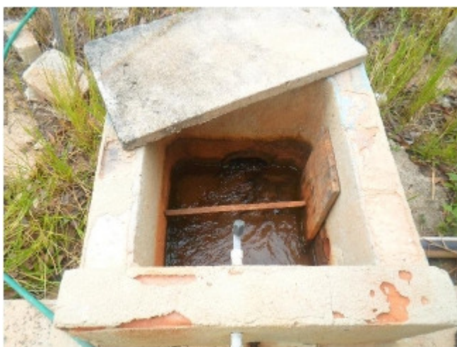
Foto 1.30 – Chegada da água da nascente (Fonte: ENGECORPS, 2015)
