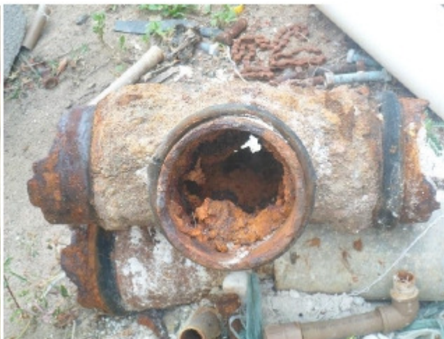
Foto 1.9 – Rede de CA rompida
