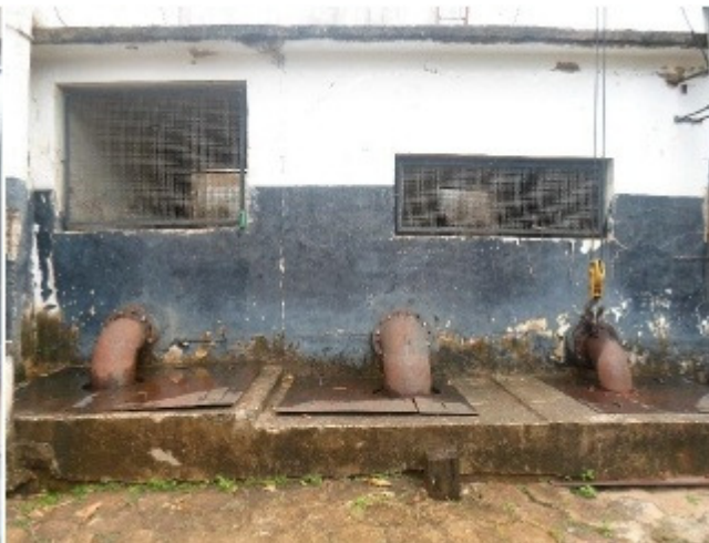
Foto 1.3 - EEAB Sede – Conjuntos motobombas
