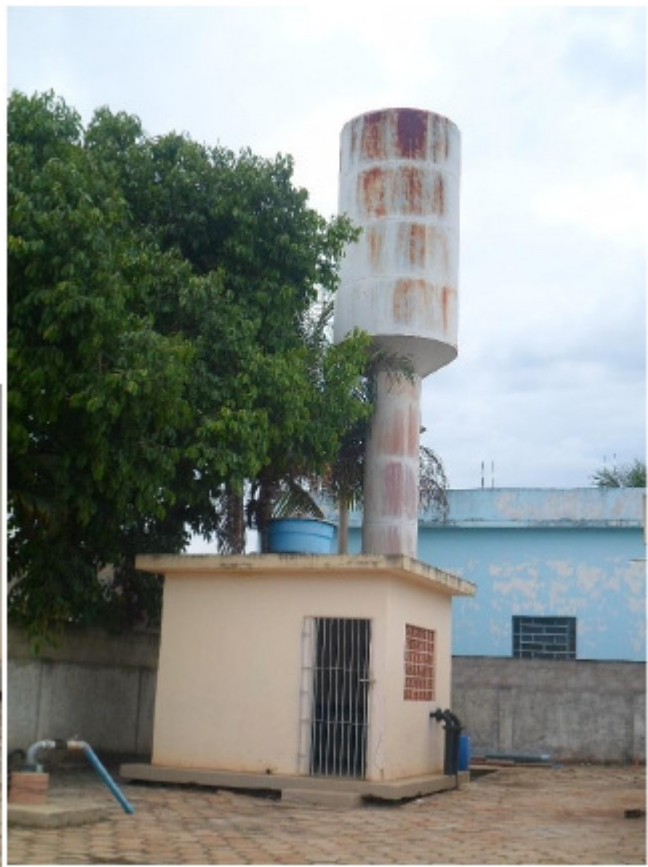
Foto 1.29 – Poço e Reservatório Elevado
