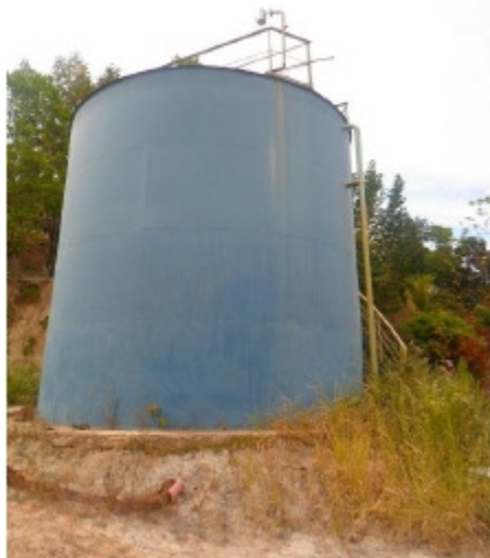
Foto 1.53 – ETE Nestor Gomes – UASB
