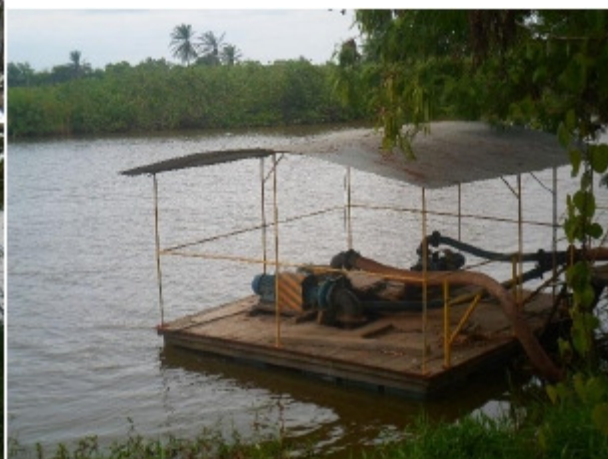
Foto 1.13 – Captação no Rio Mariricu
