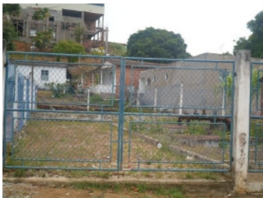
Foto 1.40 – Área destinada a implantação da EEE Cricaré
