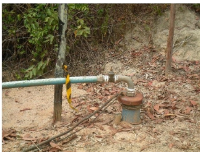
Foto 1.33 – Poço Nestor Gomes (Fonte: ENGECORPS, 2015)
