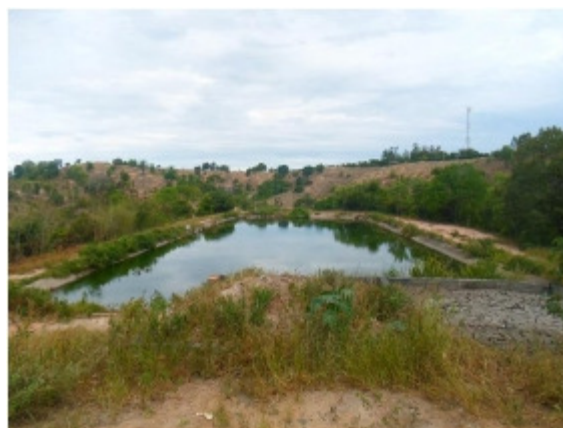
Foto 1.54 – ETE Nestor Gomes – lagoa
